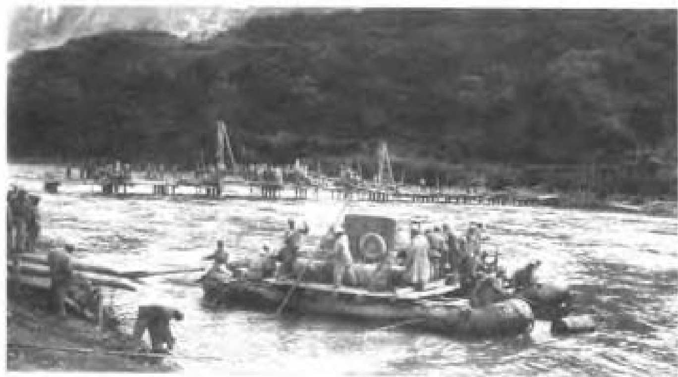
进藏部队一边抢修被破坏的桥梁，一边用橡皮舟渡江。
