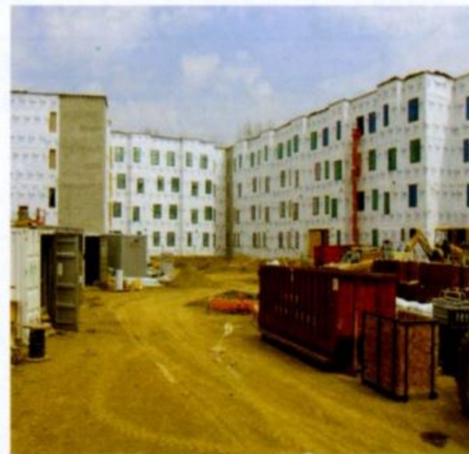
多层建筑外墙保温层外覆防风防水透汽膜
