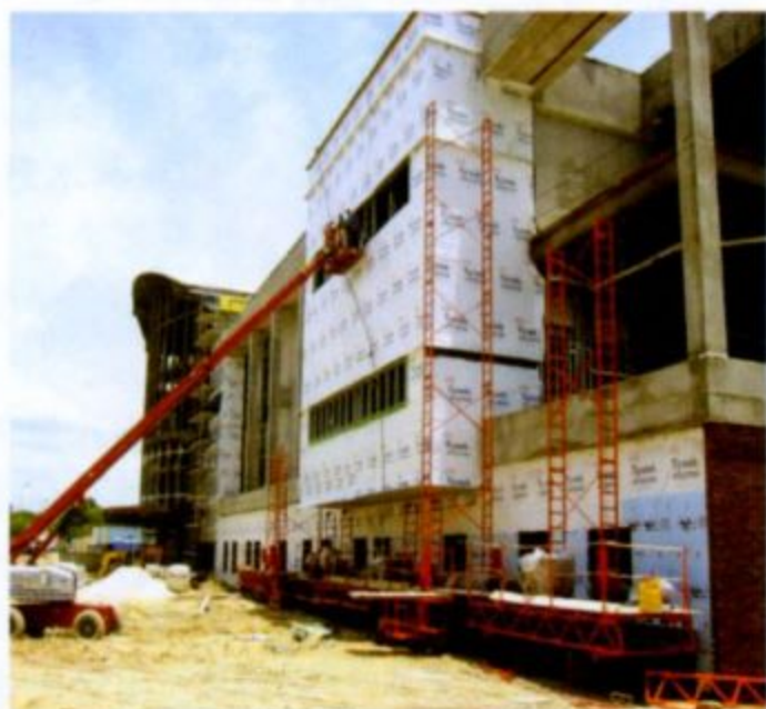
公建幕墙保温层外覆防风防水透汽膜
