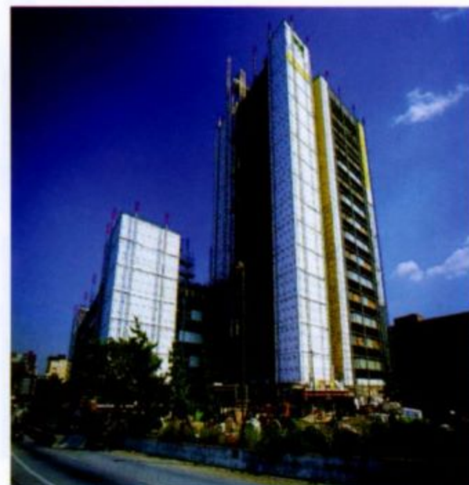
高层住宅外墙保温层外覆防风防水透汽膜
