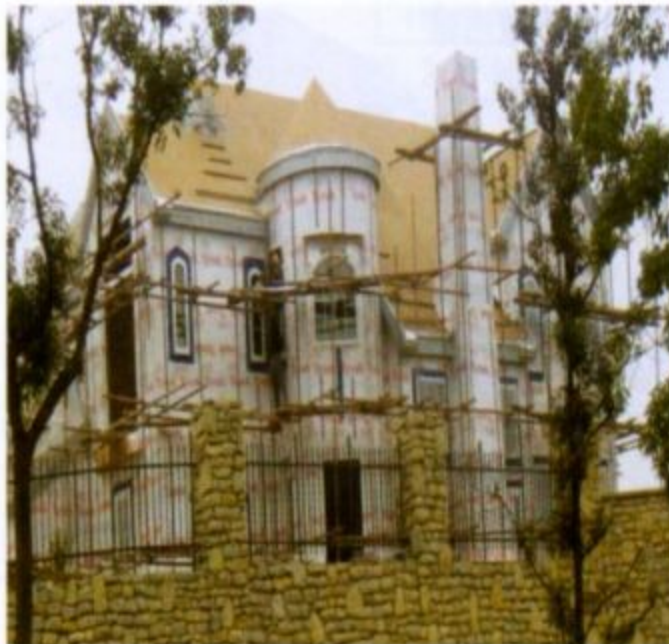
别墅外墙保温层外覆防风防水透汽膜
