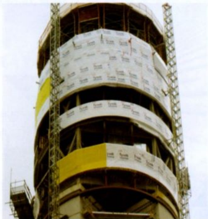
铝板幕墙保温层外覆防风防水透汽膜
